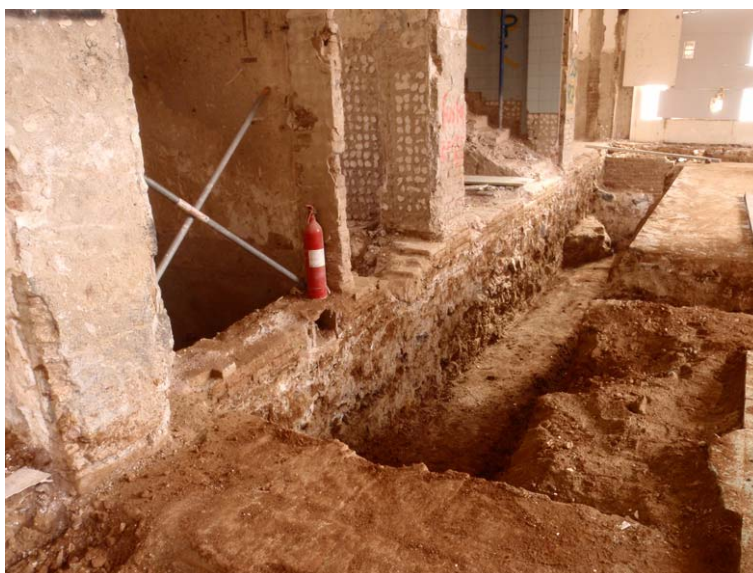
Tota la fonamentació UE 211 descoberta en fer la rasa.
