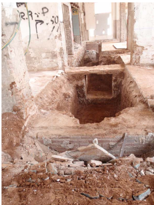
Vista general de la rasa un cop finalitzada
