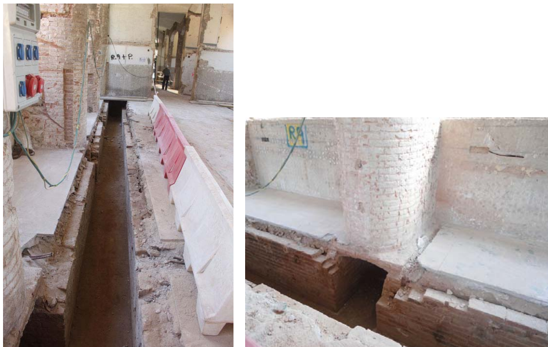
Conducció de calefacció i vista puntual de connexió amb un dels pilars
