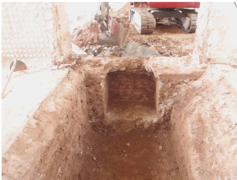
Fonamentació transversal UE 233. El mur que es veu tancant l'arcada respon a la paret de la conducció de la sala
