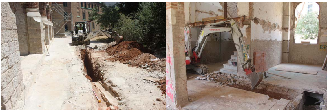
Actuació amb maquinària a l'exterior i interior del pavelló.
