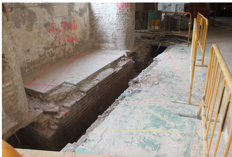
Marcat de l'àrea d'afectació de la caixa d'ascensor.
