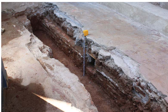
Vista del col·lector UE 111 del pavelló aparegut en un dels laterals de la rasa i en el que s'aprecia l'obertura feta per encabir la canalització UE 109.
