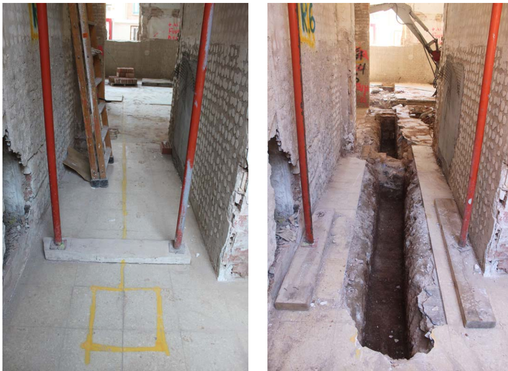
A l'esquerra la rasa marcada i a la dreta un cop finalitzada.
