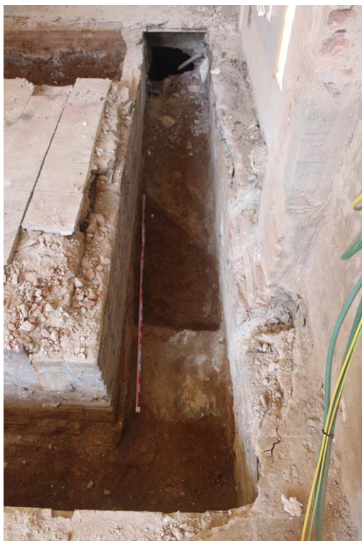
Vista general de la conducció on s'aprecia al fons el coronament de la galeria UE 225 rebaixada i l'accés al soterrani. A la part inferior la fonamentació UE 213 també rebaixada
