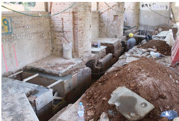
Excavació de les rases
