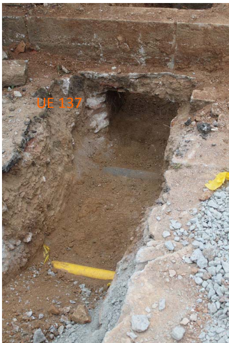
A l'esquerra tram final de la rasa on s'aprecien els diferents serveis, la construcció dels qual afectà a l'estructura UE 137
