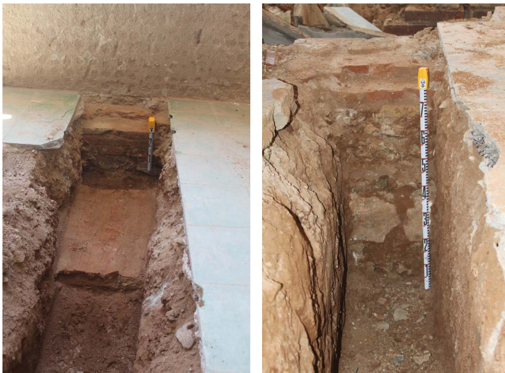
Localització del col·lector del pavelló a tocar de la fonamentació de la façana sud. Es pot observar en les dues imatges com el coronament de les fonamentacions està realitzat amb maons. A la dreta fonamentació UE 213.
